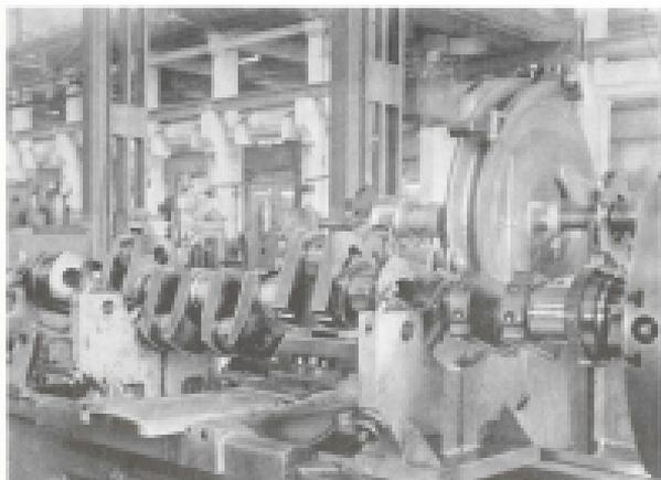
Lavorazione di un albero a manovella per motore Diesel destinato ad una motonave
